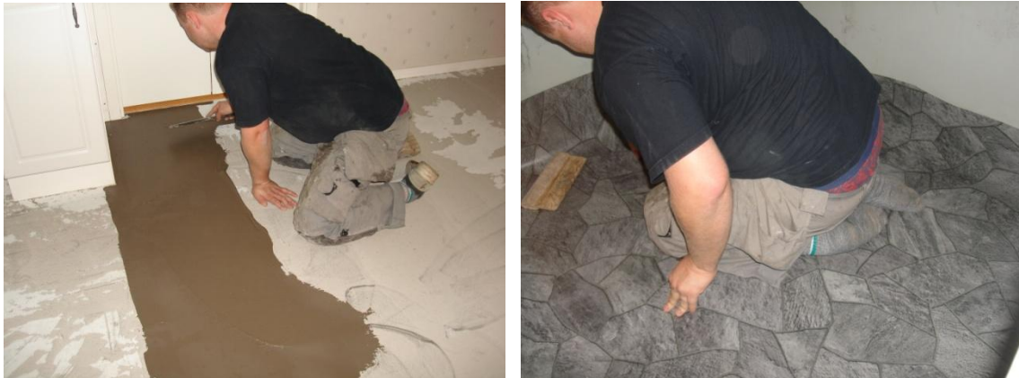
Figur 24 a och b. Testpilot 1 spacklar respektive lägger golv.
