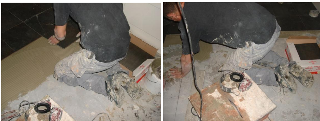
Figur 25 a och b. Testpilot 2 lägger klinker. Bakåtlutad respektive halvt framåtlutad.
